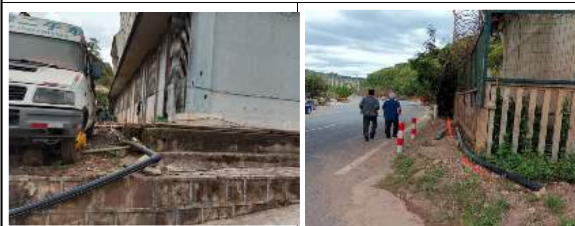
从东侧生活区管道铺设出项目区
