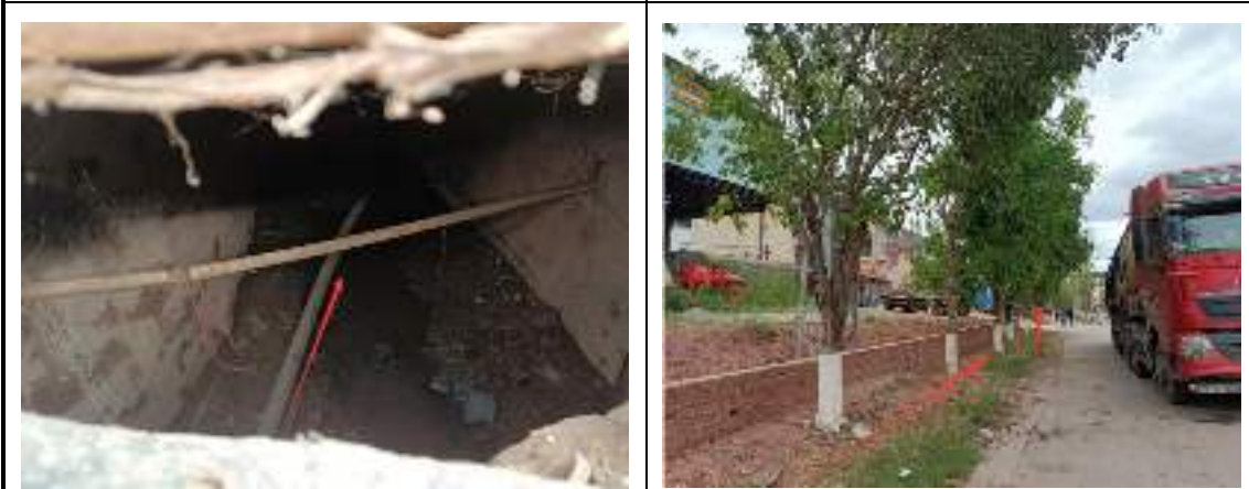
管道沿着 G27 国道旁的暗沟铺设
